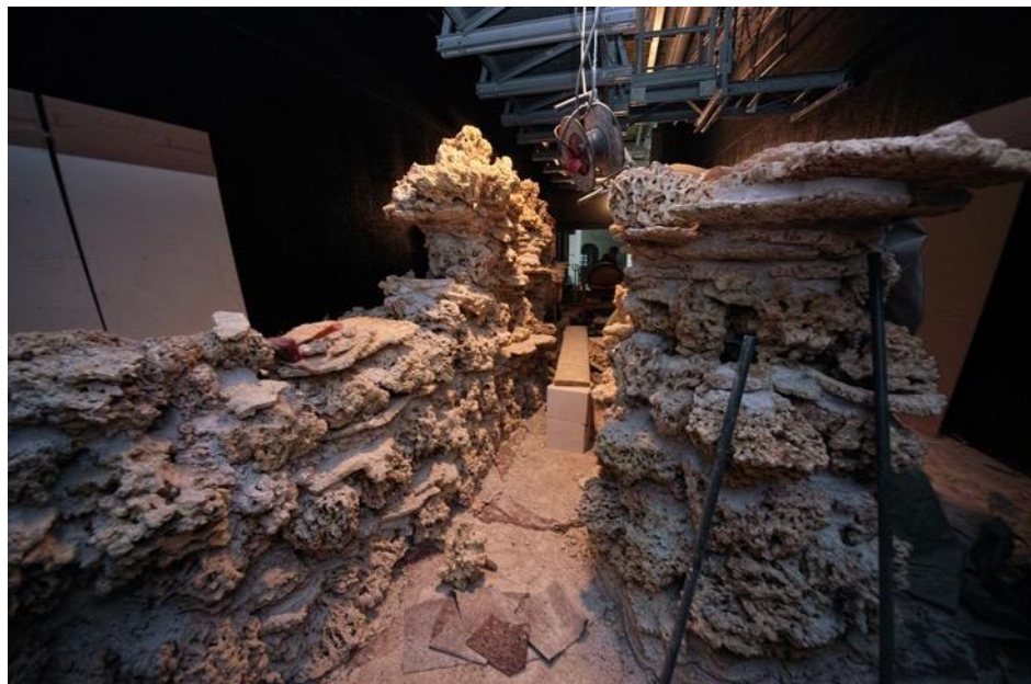
Abb. 15: Riffaufbau mit Spezialarmierungen
