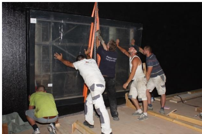
Abb. 9: Einbau der grossen Acryl-Scheiben
