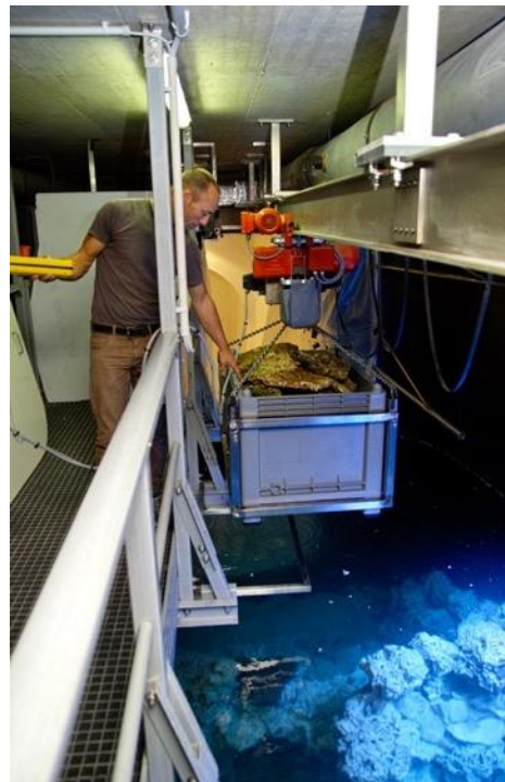
Abb. 10: GFK-Bedienersteg und Laufkatzbahn bei der Einbringung der lebenden Steine
