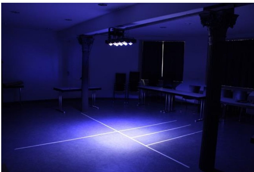
Abb. 18: Vermessung der LED-Leuchten
